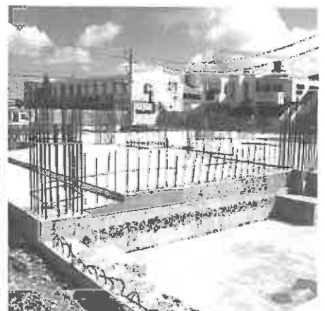
10月18日。1階土間のコンクリート打設後の様子。
