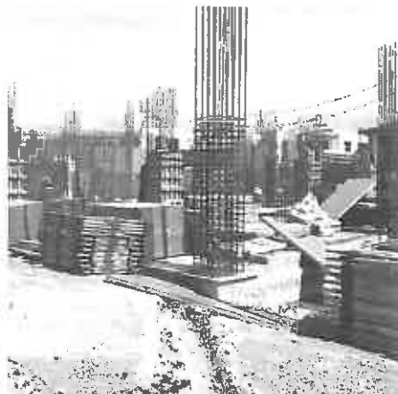
10月25日。2階に立ち上がる柱・壁の配筋。
